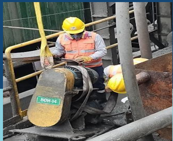
DESMONTAJE DE BOMBAS
