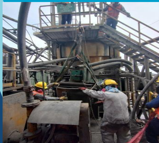
DESMONTAJE DE BOMBAS
