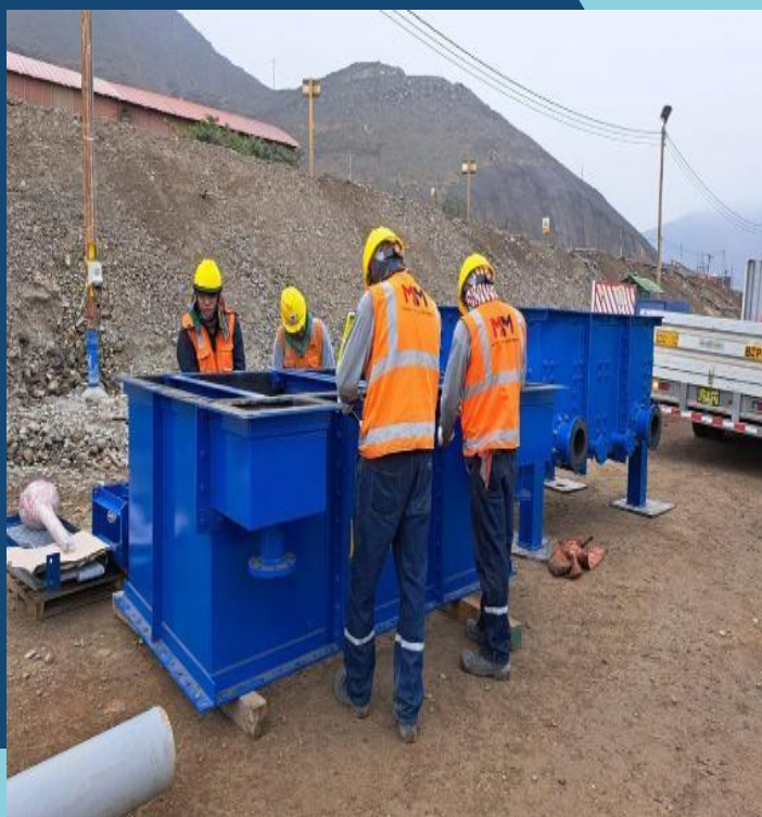
INSTALACIÓN DE CAJÓN DE BOMBAS PARA PULPA MINERAL
