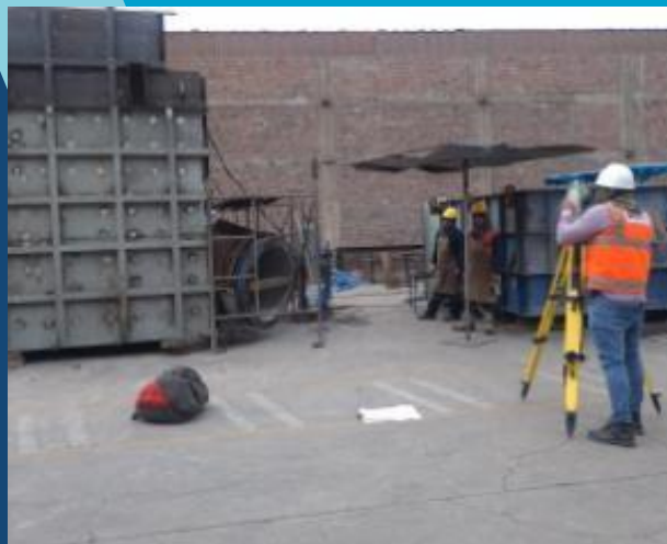
MANTENIMIENTO DE TRANSFER BOX
