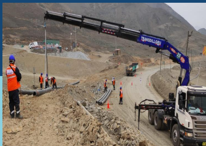
MONTAJE DE PIPE LINE HDPE. MINERA COLQUISIRI S.A.
