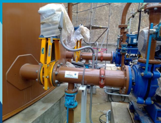
MONTAJE DE BOMBAS
