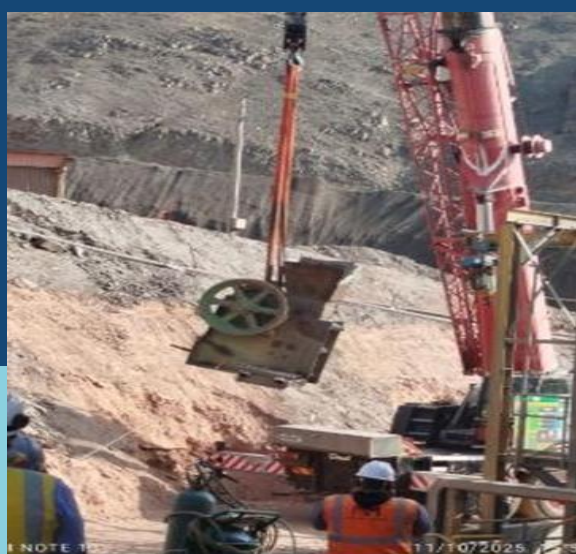
DESMONTAJE DE PLANTA DE CHANCADO
