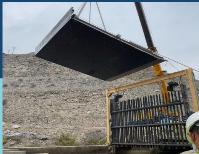
MONTAJE SUPRESOR DE OLEAJE. CELEPSA
