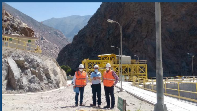
FABRICACIÓN Y MONTAJE DE DESVIADOR DE SÓLIDOS
