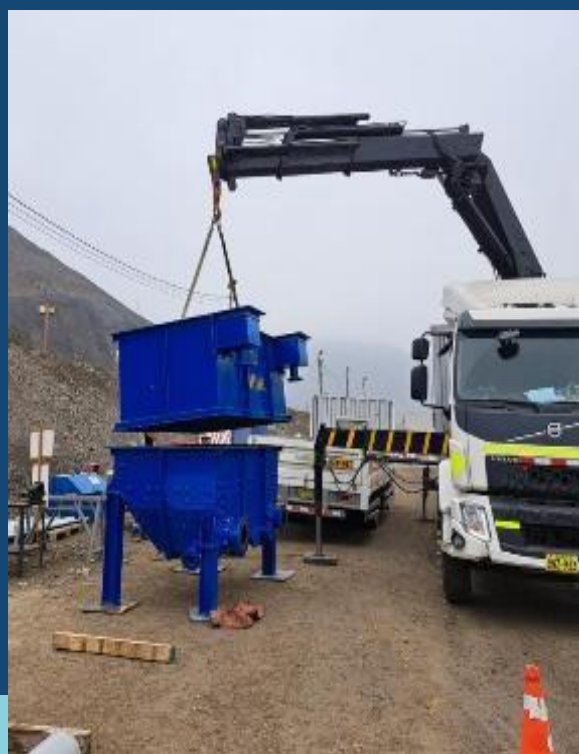
INSTALACIÓN DE CAJÓN DE BOMBAS PARA PULPA MINERAL
