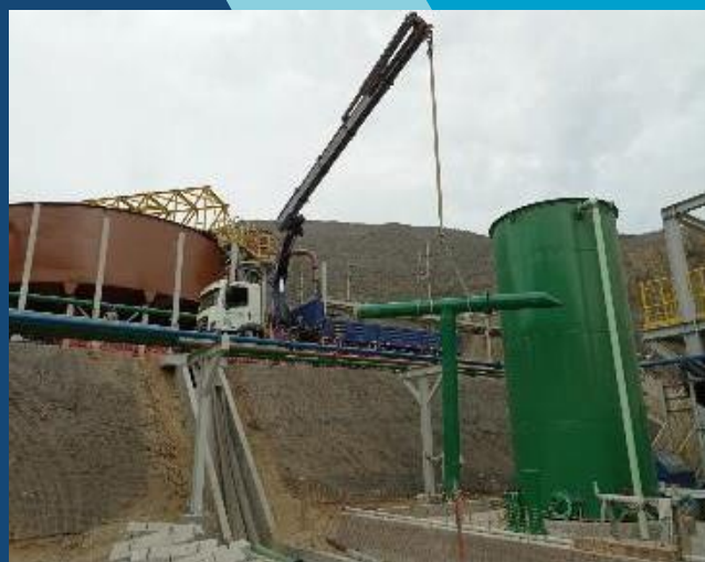
MONTAJE DE PIPE LINE MINERA COLQUISIRI S.A.
