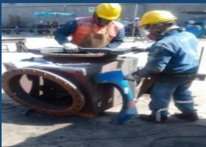
MANTENIMIENTO DE CAJONES DE PASO
