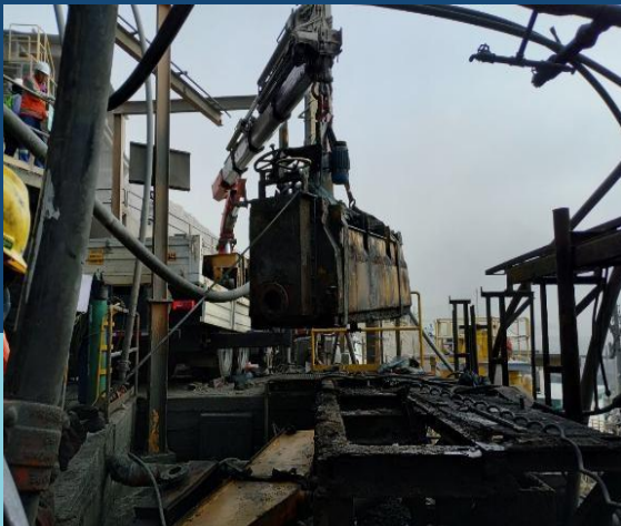
DESMONTAJE DE BANCO DE CELDAS OK
