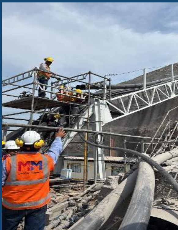
CONSTRUCCIÓN DE PIPE RACK
