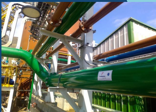
MONTAJE DE PIPING EN OBRA
