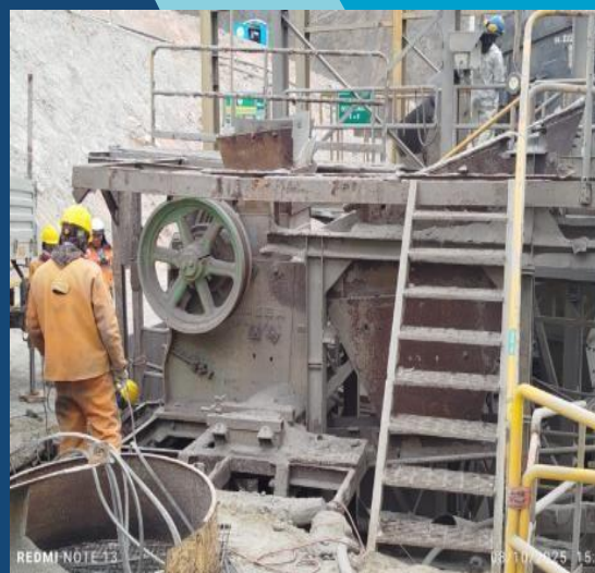
DESMONTAJE DE PLANTA DE CHANCADO
